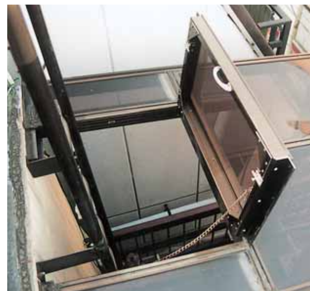
テラス屋根を開閉フタにしました。 (東京都台東区)
