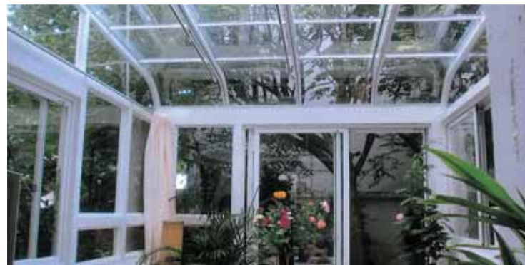
(栃木県日光市 レストラン) [軒高:H3.4M、出巾:2.7M、間口:7.2M、被覆材:t-6.8 網入りトーマイ PHW]
