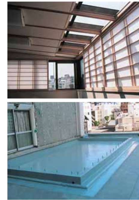
8階屋上 (東京都港区六本木 Nビル) [出巾:3.5M、間口:7.5M、屋根材:ポリカーボネート板+-6.0、側面材:アルミ複合板+-3.0]
