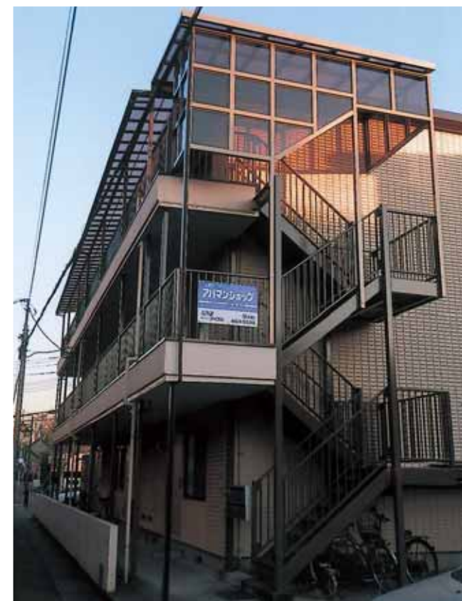
3階廊下・階段やね工事 (埼玉県さいたま市 クレセント本郷)
