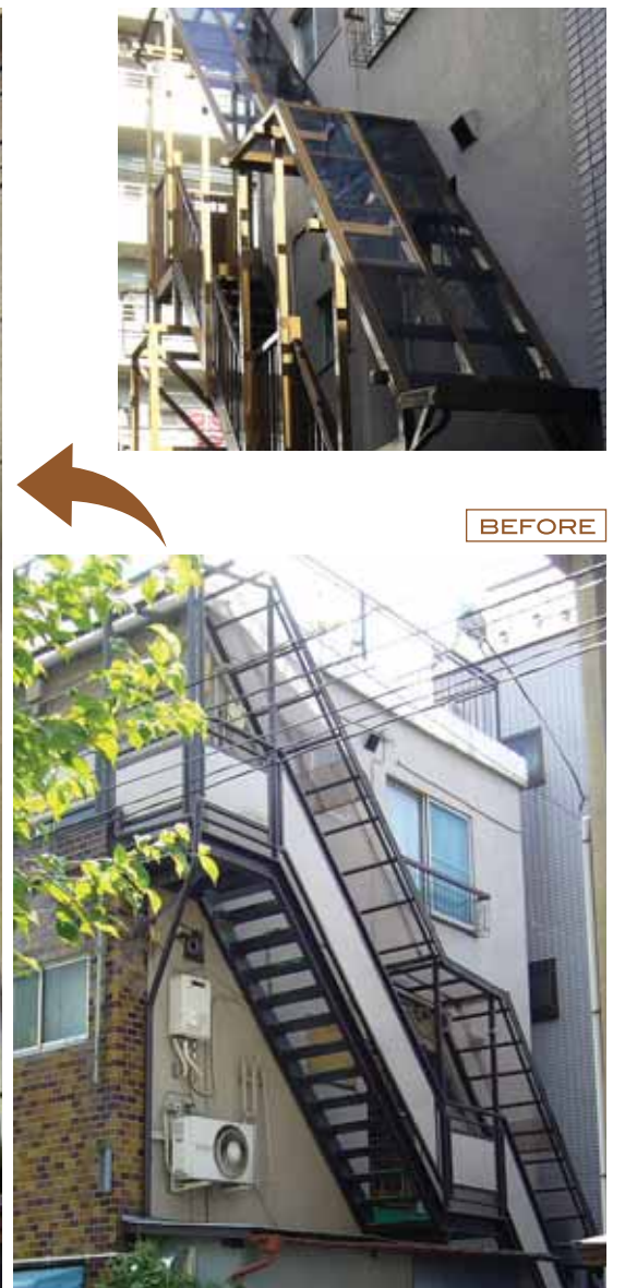
スチール階段及びスチール波板テラスを、アルミ階段(支柱補強)及びアルミテラス(ポリカーボ板)にリニューアル!
