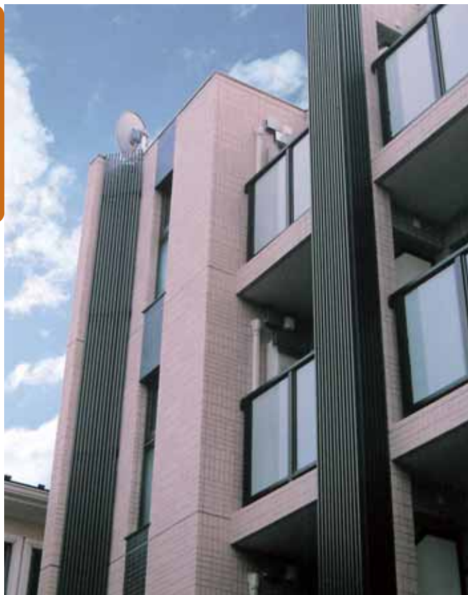
外部露出配管パイプ類の隠し化粧として (埼玉県さいたま市)
