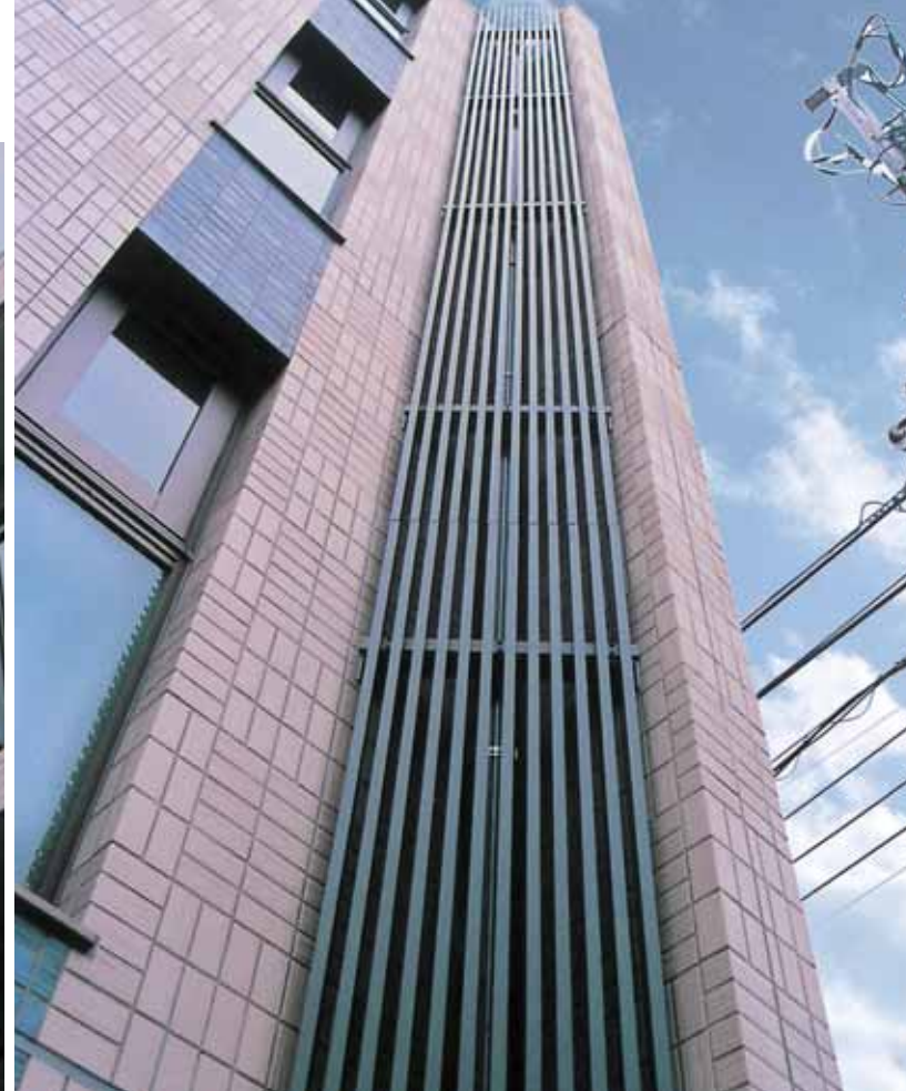
外部露出配管パイプ類の隠し化粧として (埼玉県さいたま市)
