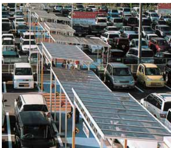
独立式 片流れやね 駐車場内歩行通路 (神奈川県厚木市 Jパチンコ店) [間口:5.0M、間口:2.5M、奥行:110M、 屋根材:ポリカーボネート板t-3.0]
