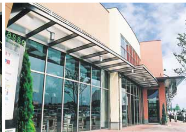
(千葉県 幕張サービスエリア内(上・下線共)) 食堂・売店棟 庇 [ポリカーボネート板t-8.0]
