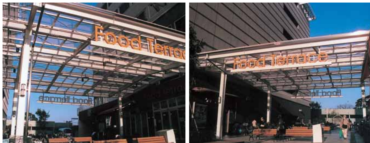
強化ガラス・TP (埼玉県久喜市 イトーヨーカドー) [間口:12.0M、奥行:13.5M、被覆材:t-6.8 網入りトーマイガラス PHW]
