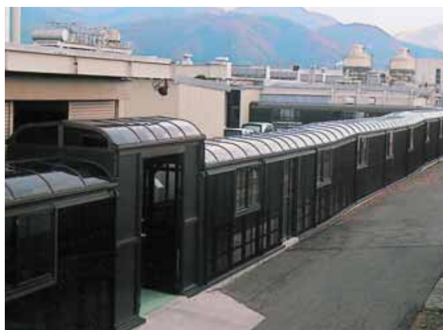
東北リズム株式会社 工場内通路 積雪対応 (福島県会津若松市) [間口:1.8M、奥行延長:95M、屋根材:ポリカーボネート板(耐候処理)×-3.0、側面材:ポリカーボネート波板]
