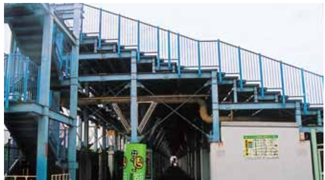
バックスタンド・雨水対策工事 (千葉県柏市 日立・柏レイソルサッカー場)(柏スタジアム) [間口:8.0M、奥行:110.5M、被覆材:t-6.8 網入りトーマイ PHW]
