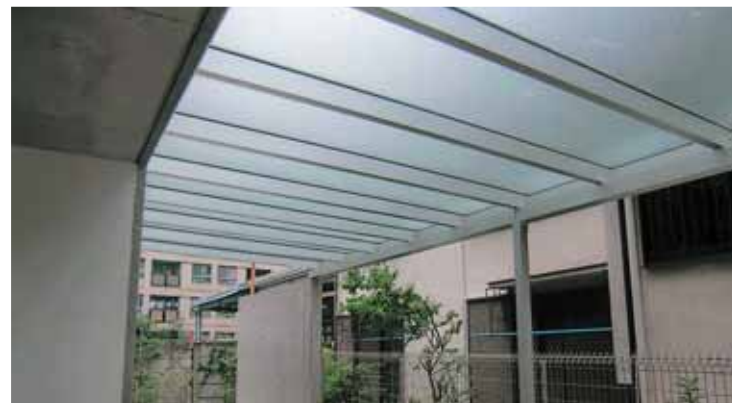
強化ガラス・TP (埼玉県久喜市 イトーヨーカドー) [間口:12.0M、奥行:13.5M、被覆材:t-6.8 網入りトーマイガラス PHW]
