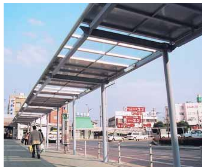
(千葉 JR新検見川駅前ロータリー改修工事) [屋根シャルター:ℓ180M、屋根材:アルミ板+-2.0、PHW+-6.8、支材・梁:st(ゼネコン)]
