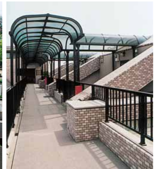
(埼玉県川口市 マンション通路)
