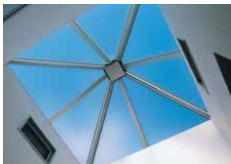
四角錐トップライト (埼玉県栗橋町 小右衛門公園トイレ)
