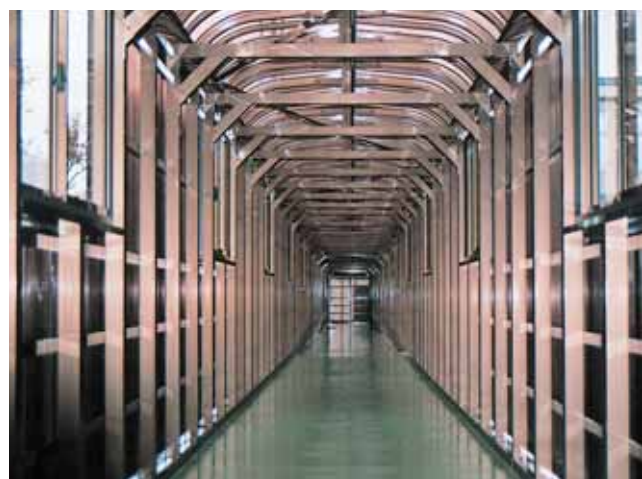
東北リズム株式会社 工場内通路 積雪対応 (福島県会津若松市) [間口:1.8M、奥行延長:95M、屋根材:ポリカーボネート板(耐候処理)×-3.0、側面材:ポリカーボネート波板]
