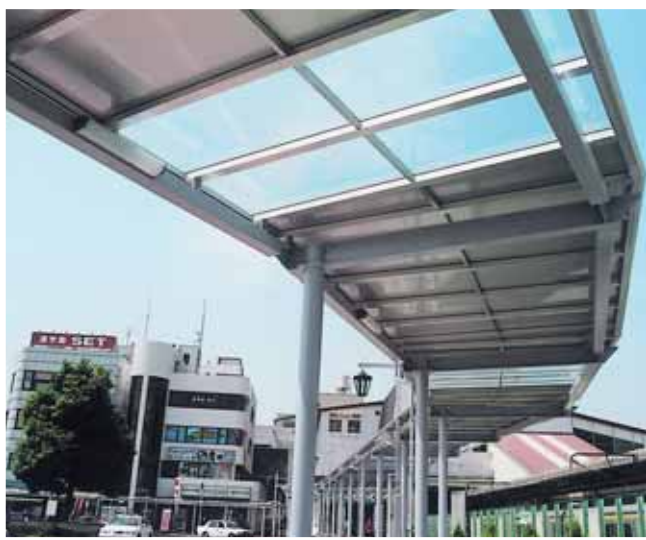
(千葉 JR新検見川駅前ロータリー改修工事) [屋根シャルター:ℓ180M、屋根材:アルミ板+-2.0、PHW+-6.8、支材・梁:st(ゼネコン)]
