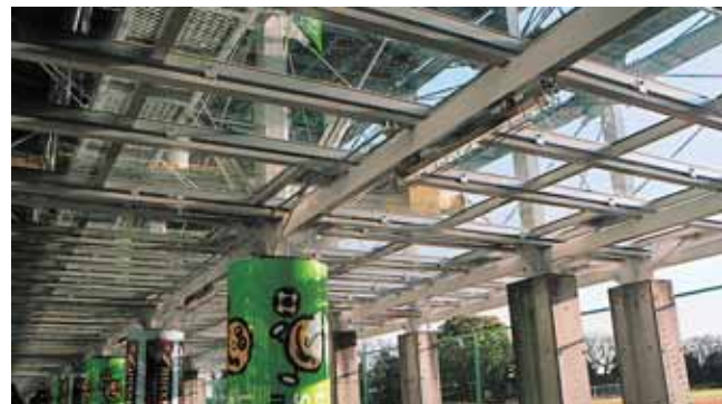
バックスタンド・雨水対策工事 (千葉県柏市 日立・柏レイソルサッカー場)(柏スタジアム) [間口:8.0M、奥行:110.5M、被覆材:t-6.8 網入りトーマイ PHW]
