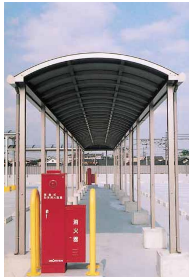
(埼玉県川口市 スーパーベルク川口屋上) [間口:2.2M、延長:72M、屋根材:アルミ板+-1.5 シルバー]
